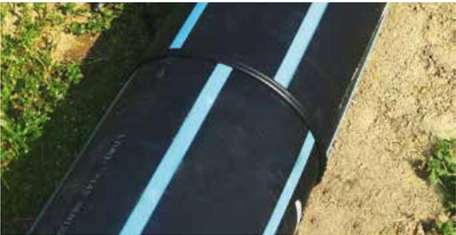
Il sistema di giunzione testa a testa, tipico delle condotte di PE, conferisce alle reti una condizione di perfetta continuità, quindi tenuta stagna assoluta e permanente. Tale tipo di giunzione fornisce le migliori garanzie di affidabilità ed efficienza per sistemi in pressione e non. Inoltre impedisce il deleterio effetto della penetrazione radicale, che in prossimità delle radici delle piante talvolta si riscontra nei sistemi di tubazioni a bicchiere.
