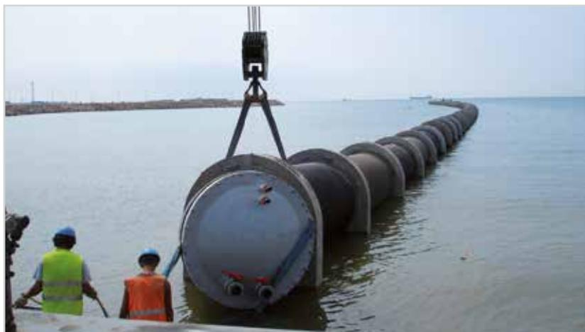
varo a mare tubi PE Spiraliati DN 3000 mm con blocchi di affondamento in CLS
