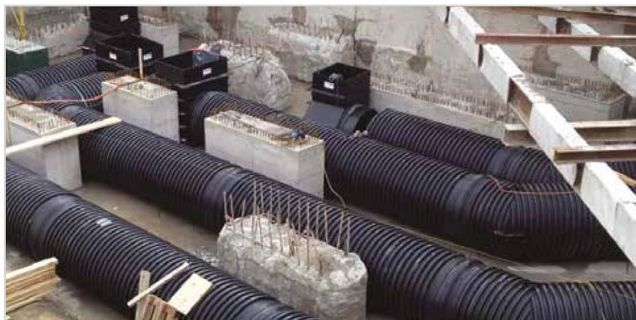
sistema di aereazione industriale sotto pavimento, DN 1500 mm (CH)
