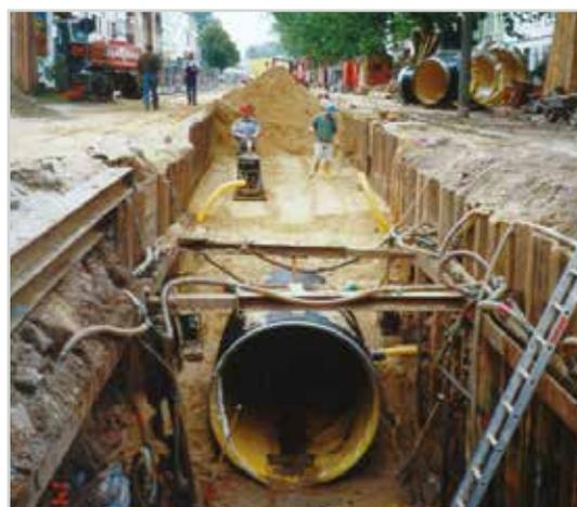
TARANTO | posa DN 2000 mm in lunghi conci presaldati fuori scavo, cantiere
